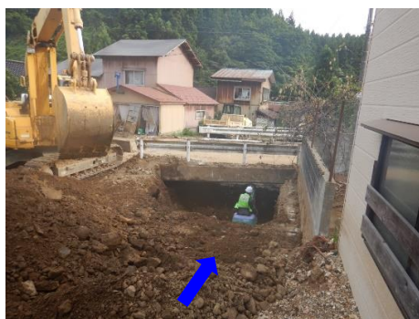
－ 土砂撤去作業状況 －
