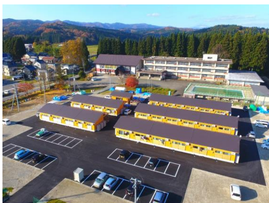
戸沢村向名高仮設団地
