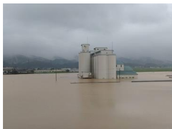
カントリーエレベーターの浸水 (酒田市竹田)
