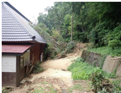
土砂等の撤去 (鮭川村大字京塚)
