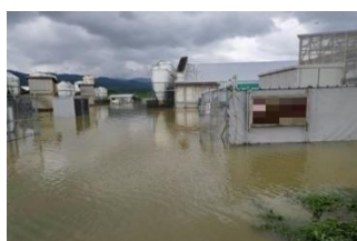
豚舎の浸水状況 (庄内町古閑)
