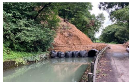
仮設水路の設置
