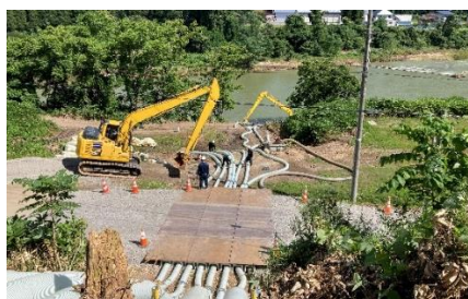
応急ポンプの設置
