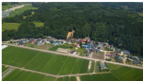
ヘリから撮影・山腹崩壊 (鮭川村大字川口)
