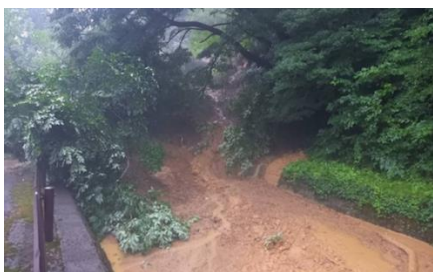
北楯大堰用水路 法面崩落
