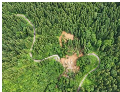
林道路体流出状況 (大蔵村清水)
