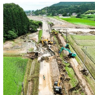
大雨災害からの復旧工事
