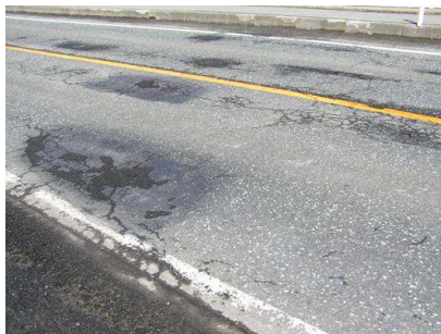
橋面と床版下面の損傷状況は関連している場合が多い
