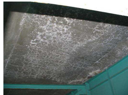
橋面と床版下面の損傷状況は関連している場合が多い
