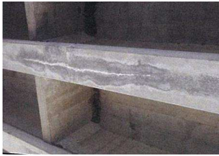
PC 桁のシースに沿ったひび割れ
