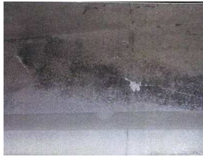
PC 桁のシースに沿ったひび割れ
