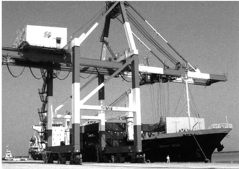
〈ガントリークレーンとコンテナ船〉
