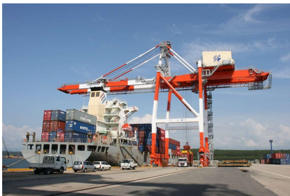
〈ガントリークレーンとコンテナ船〉
