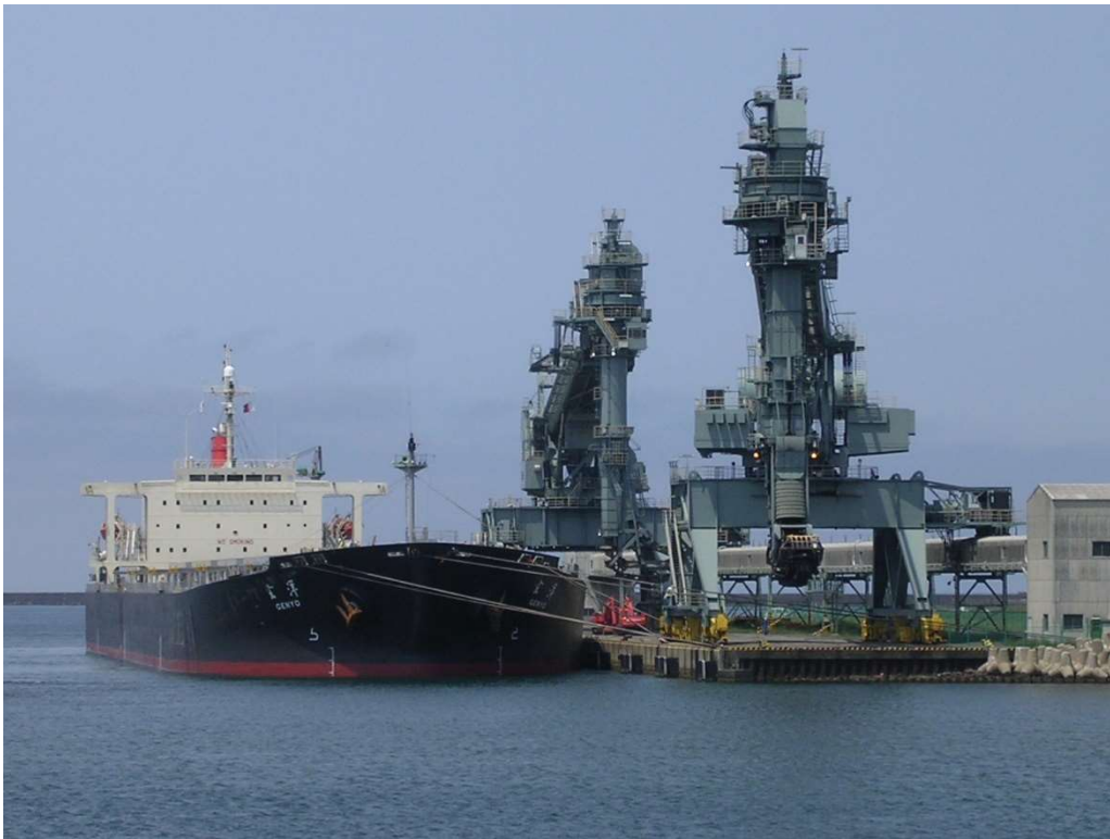
〈石炭タンカー船とアンローダー（石炭荷役機械）〉
