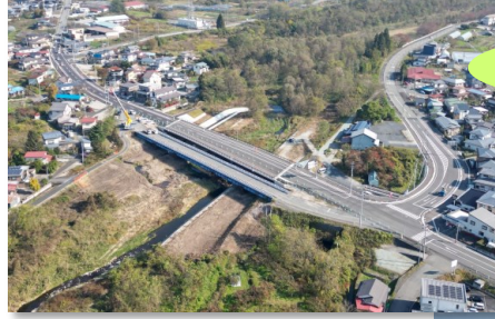
高瀬川橋全景
