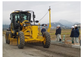
MCモータグレーダによる路盤敷ならし状況 ↑
