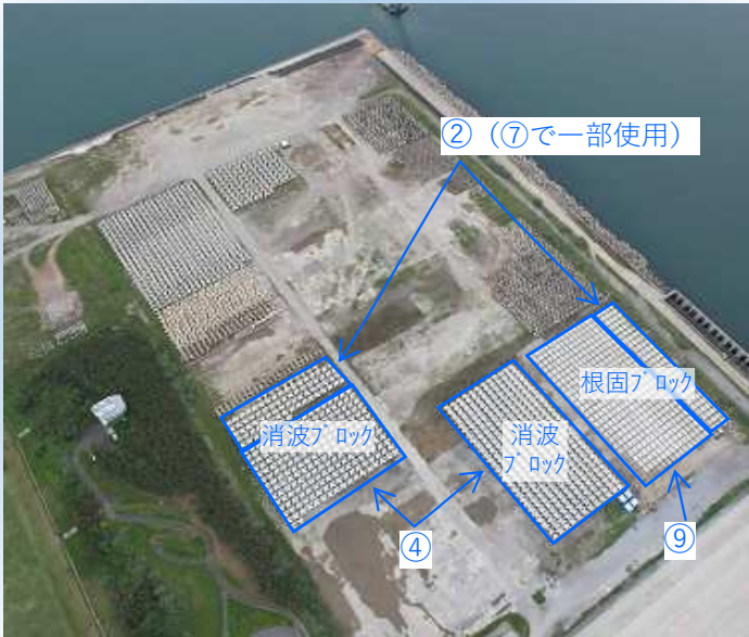
高砂・仮置きヤード
