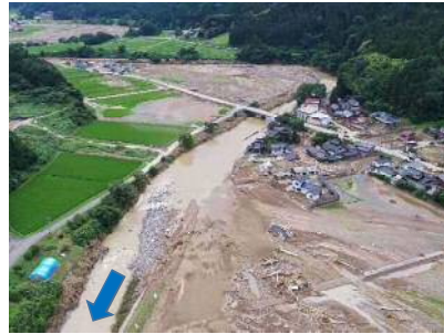
河岸浸食・浸水被害 状況
