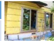
【寒さ対策・断熱化の例】 二重サッシの設置
