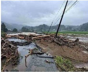
浸水被害 状況
