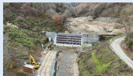
工事中写真（撮影：R6.11月）
