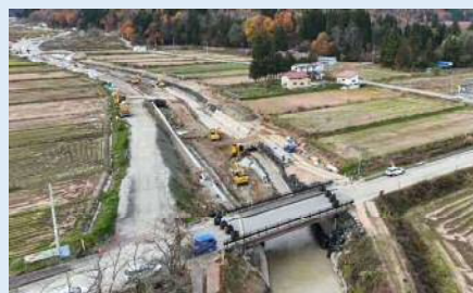
工事中写真（撮影：R6.11月）
