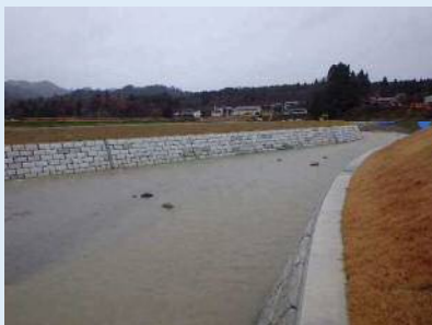
護岸完成箇所（撮影：R6.12月末）
