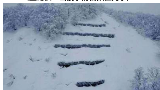
(整備後：雪崩予防柵設置完了)
