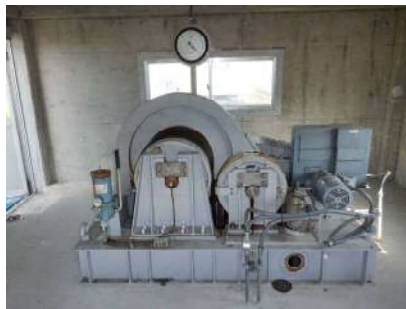
機械設備の補修
