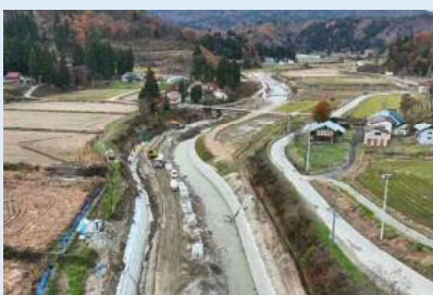
工事中写真（撮影：R6.11月）
