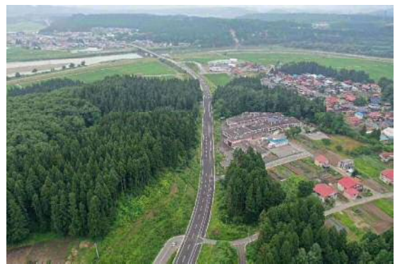
(国) 458号 (本合海バイパス工区) (R6.8.4供用開始)
