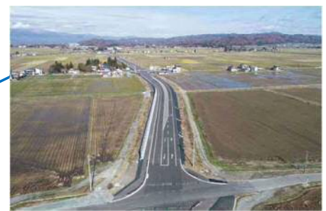
川西バイパス開通(川西町)
