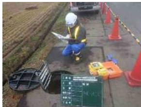
管路点検(マンホール点検)
