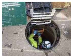
管路点検(管渠目視点検)
