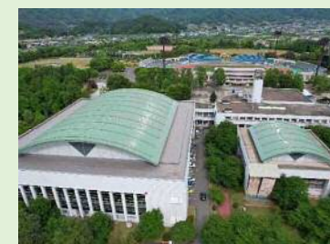
屋根改修(R6完了)
