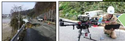
被災箇所の点群データを取得
