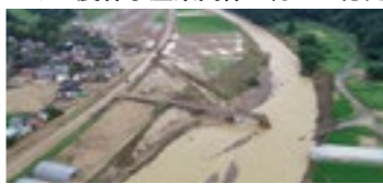
荒瀬川の氾濫状況(酒田市提供)
