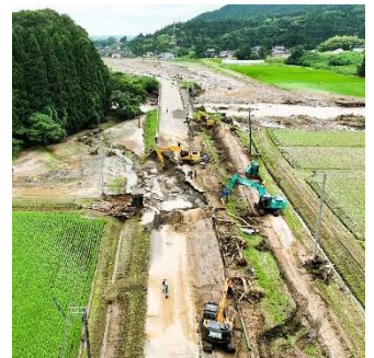
大雨災害からの復旧工事
