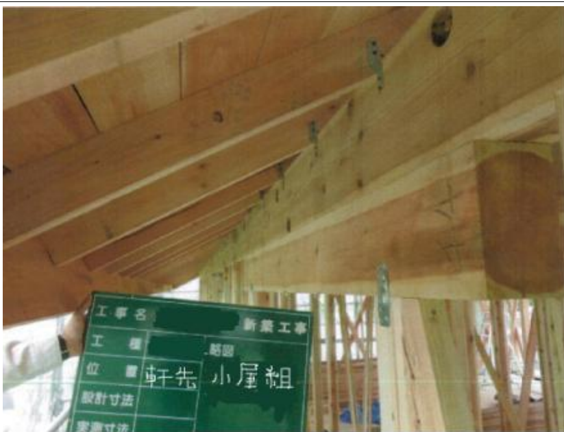
小屋組み完了 軒先部
