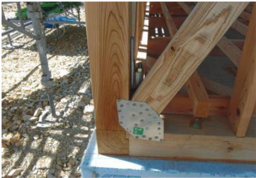
主要な軸組み完了 下部
