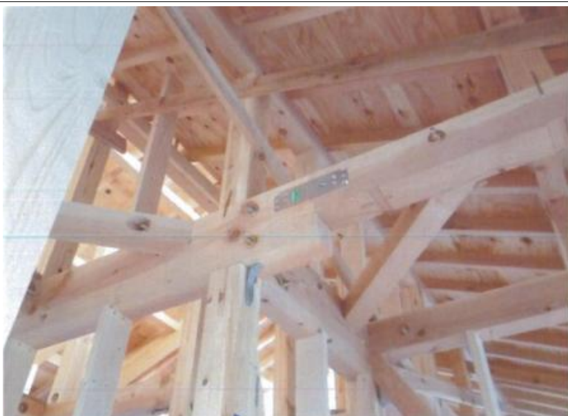
小屋組み完了 継手、仕口部
