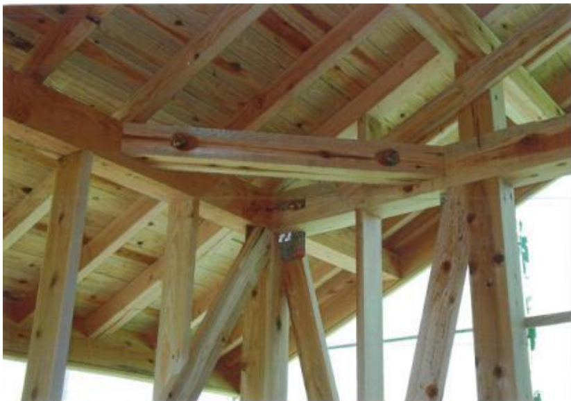
小屋組み完了 火打ち、仕口部
