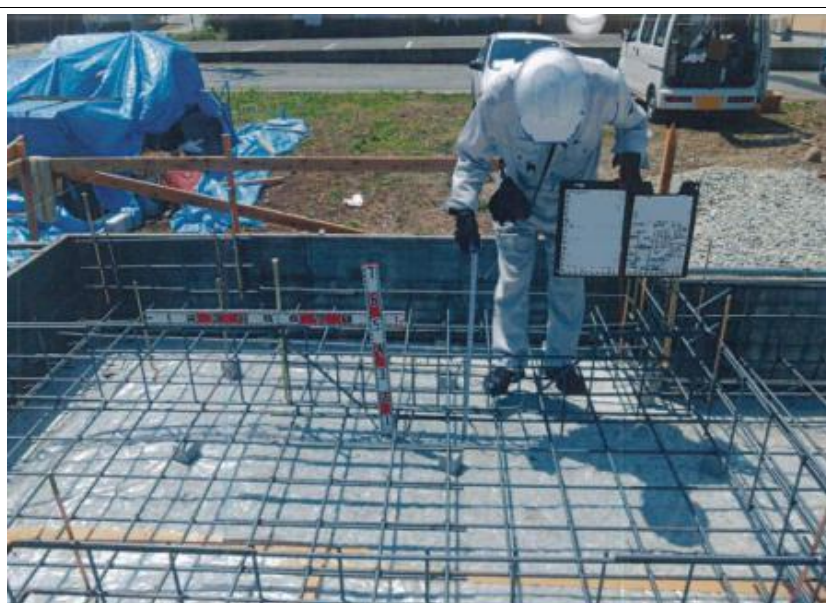
基礎配筋完了 検査状況 アンカーボルト及びHD金物 用ボルト設置状況
