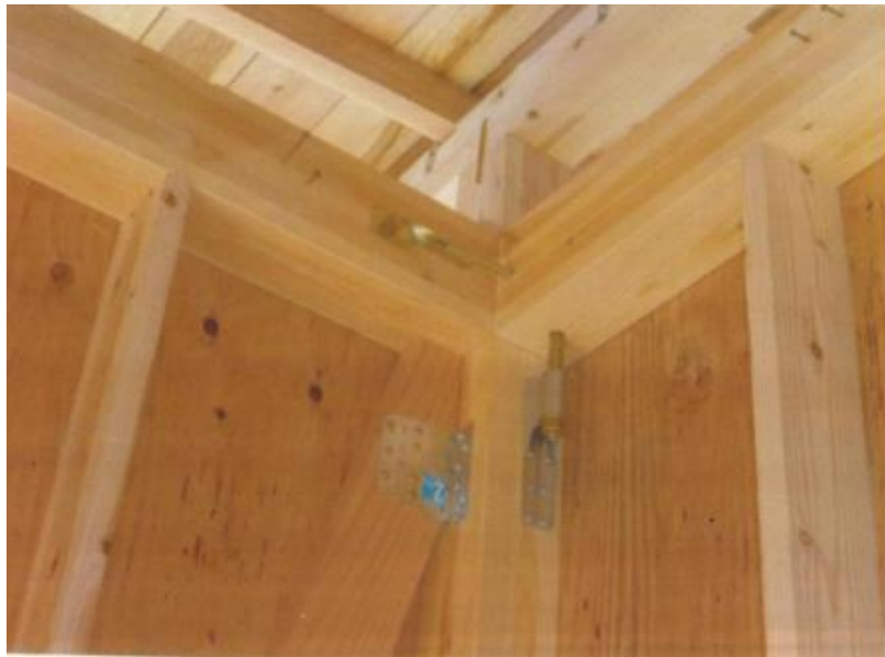
主要な軸組み完了 上部
