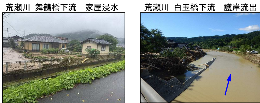
図 1.4 令和6年7月洪水の被災状況
