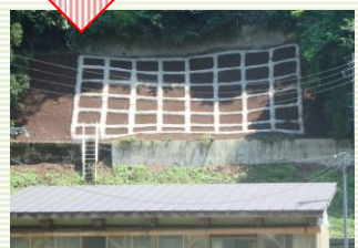
完成した法枠工
