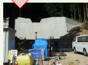
施工中の治山ダム
