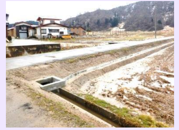
排水路設置工事の状況
