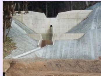
完成した治山ダム（正面）
