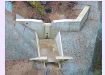
完成した治山ダム（上空）
