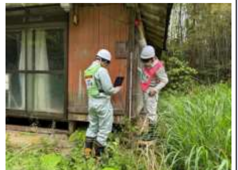
現地確認（建物の傾き測定）
