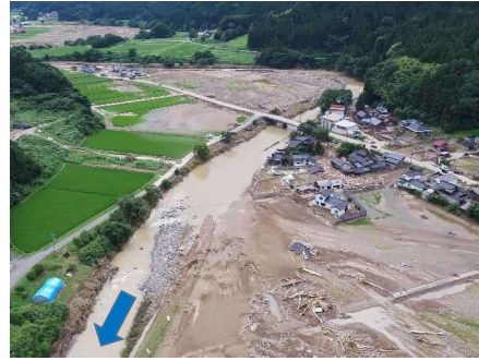
河岸浸食・浸水被害 状況
