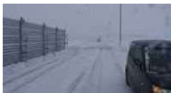
（整備後：防雪柵設置完了）
