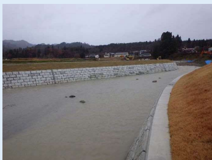
護岸完成箇所（撮影：R6.12月末）
