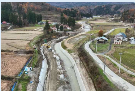
工事中写真（撮影：R6.11月）
