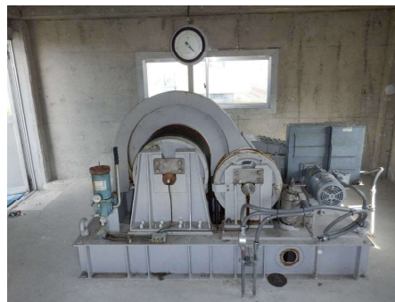
機械設備の補修
