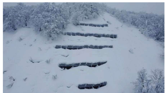
（整備後：雪崩予防柵設置完了）
