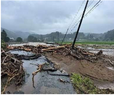
浸水被害 状況
