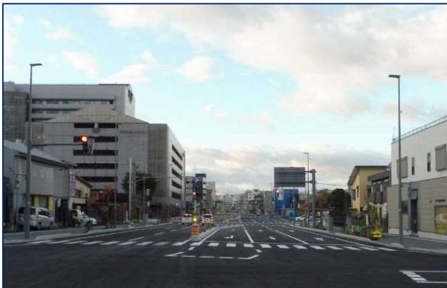
R2事業完了 旅籠町八日町線(七日町工区)(山形市)
