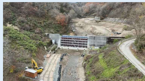
工事中写真（撮影：R6.11月）
