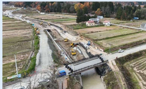
工事中写真（撮影：R6.11月）
