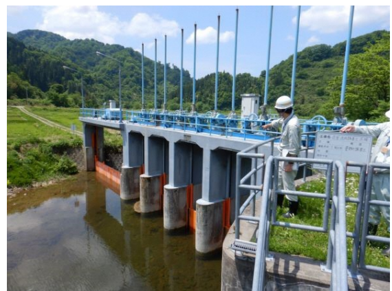
菅野代頭首工の点検の様子（鶴岡市）
