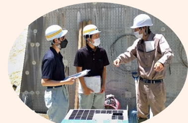
女殺沢川砂防えん堤工事
