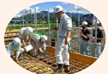
湯尻川護岸及び排水樋門工事
