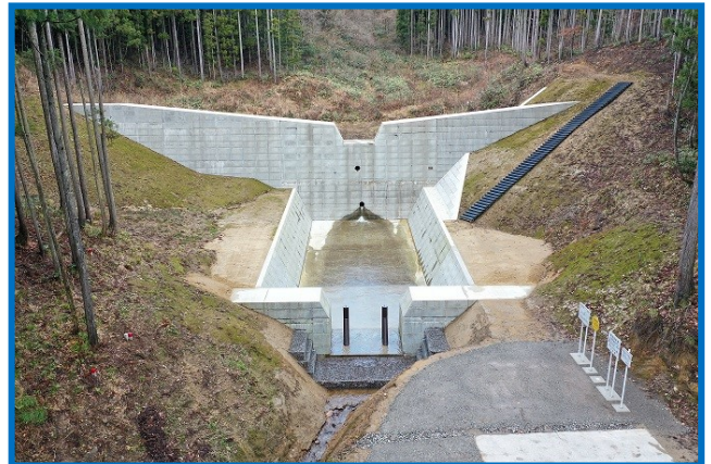
女殺沢川砂防堰堤
