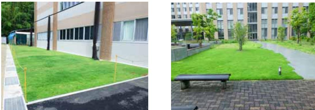
注：瓦等を原料とし、栄養分を含む基盤材を施工した例
