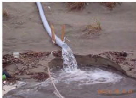
【11月28日ポンプで排水し、 海までの導水状況】
