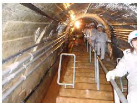
④荒沢ダム監査路内
