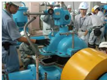
慎重に上ケーシング取り外し
