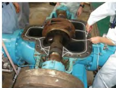
ケーシングパッキン取付け
