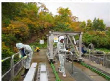
ゲート手すりの取り外し
