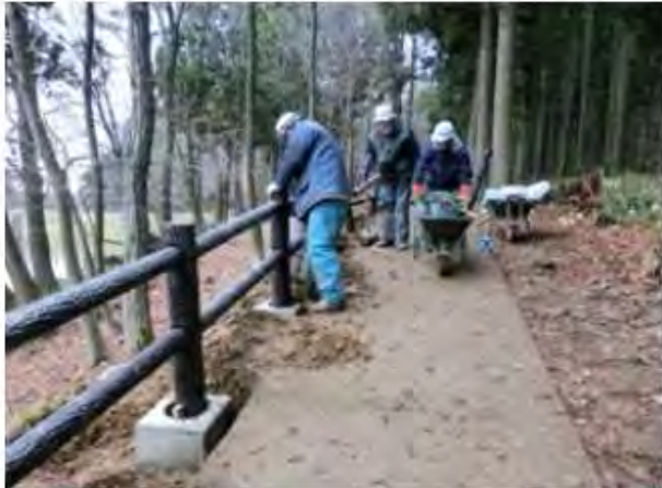
山寺ため池 転落防止柵の改修工事
