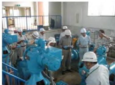
ポンプ分解点検作業の段取り説明
