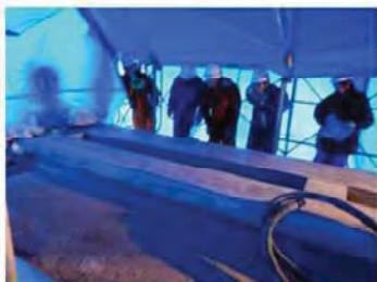
手前が高圧洗浄を終えた状態
