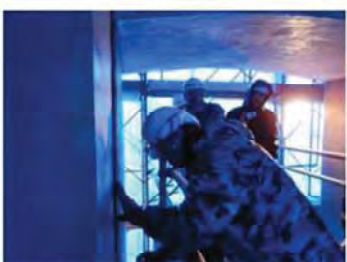
モルタルを吹付けたら金ゴテで仕上げる
