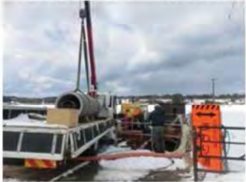
推進管を発進立坑へ
