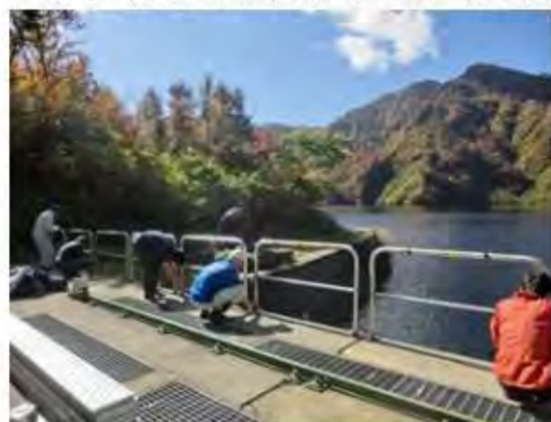
ゲート手すりの取り外し
