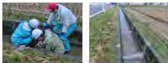
4.左官コテで仕上げ 5.出来上がり
