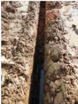
掘って管を入れて、瓦チップを投入
