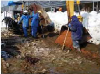
給水渠の施工状況
