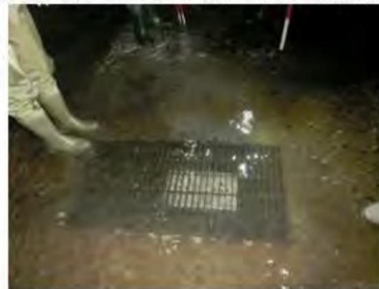
流量計の状況
