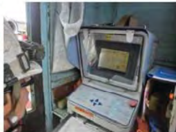
操作盤で管の中心のズレを管理
