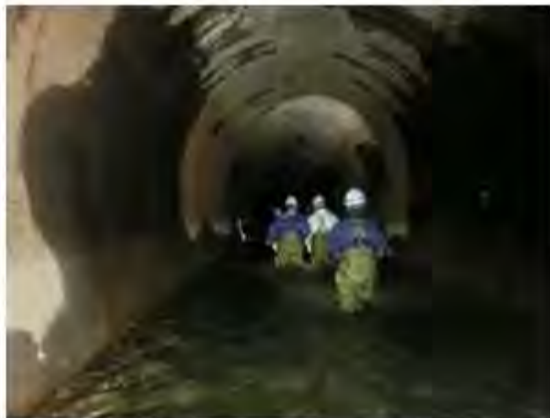
トンネル出口に向かい、水深が深くなる
