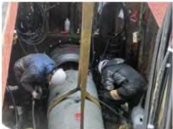
管の接続作業状況
