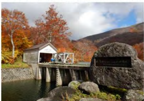
ゲートでの作業状況
