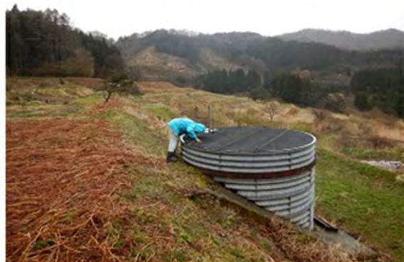
集水井の内部確認
