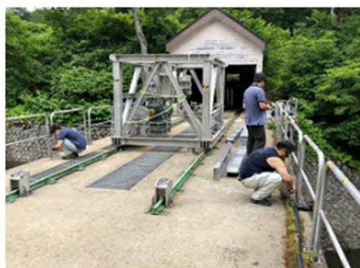
手すりを設置します
