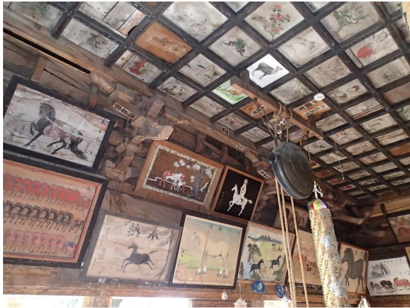
観音堂外陣 天井
