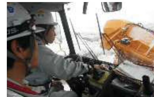
除雪車両操作状況
