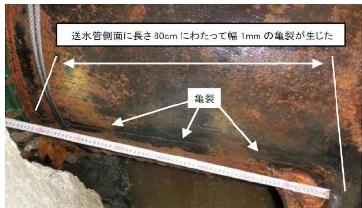
東日本大震災被災（酒田工業用水道 φ1000 鋳鉄管の亀裂）
