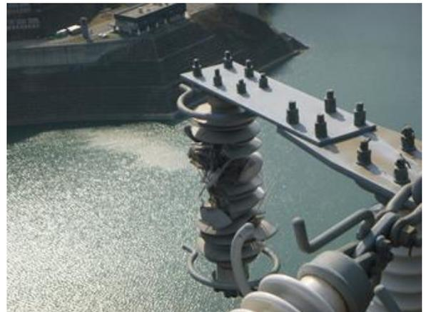
落雷による避雷設備損傷状況
