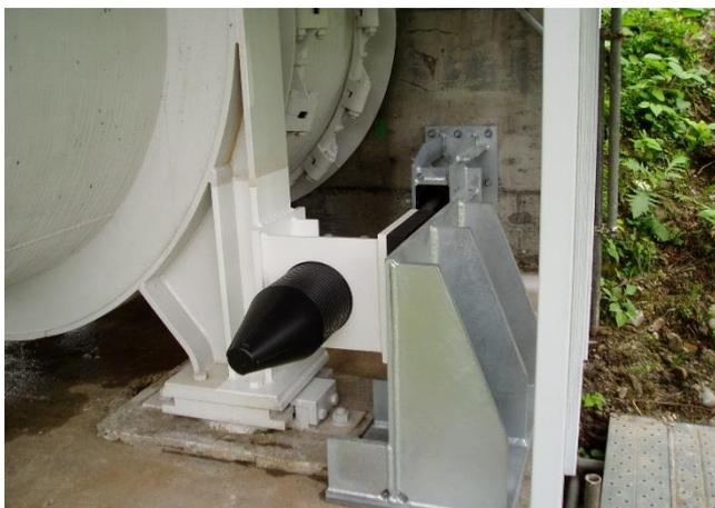
水管橋落橋防止装置
