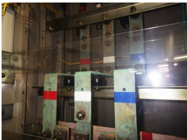
電気設備盤内の腐食状況(銅鍍)
