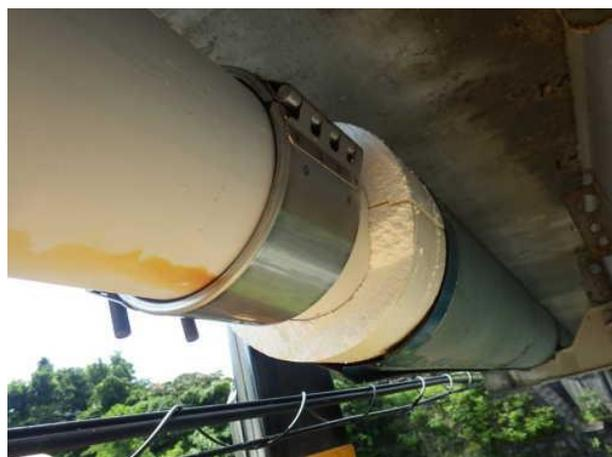
止水バンドによる漏水補修
