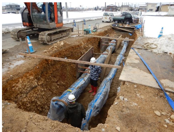
送水管耐震化工事(村山)
