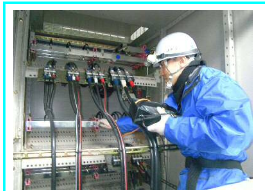
電気設備の点検
