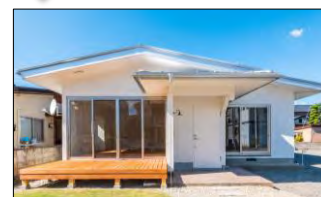
【住替え支援モデル事業での利活用事例】 上山市の空き家を公社が買取り、芸工大のデザインで リノベーション工事後、子育て世帯へ販売した事例
