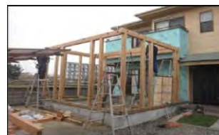
【三世帯世帯でのリフォームの例】 居室の増築工事
