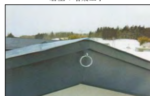
【克雪化リフォームの例】 雪下ろし用命綱を固定する金具の取付け
