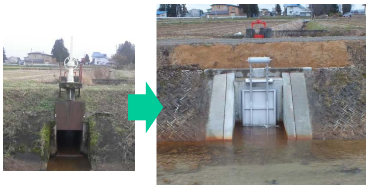
更新時のゲート操作の無人化の推進 (フラップゲート化)
