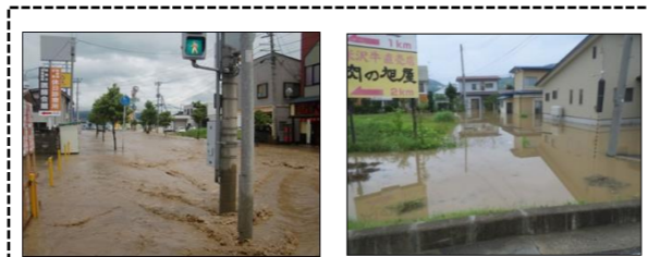
▲市街地の浸水被害状況(平成 25 年 7 月)
