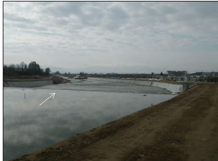
▲河川災害復旧等関連緊急事業による整備後の状況(平成 29 年 3 月)
