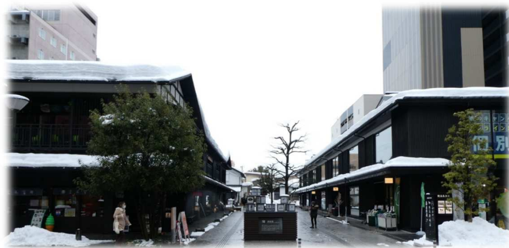
七日町第5ブロック南地区第一種市街地再開発事業（H28-R2：山形市）
