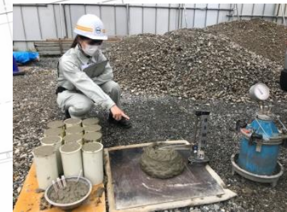
工事監理の様子 コンクリート強度確認
