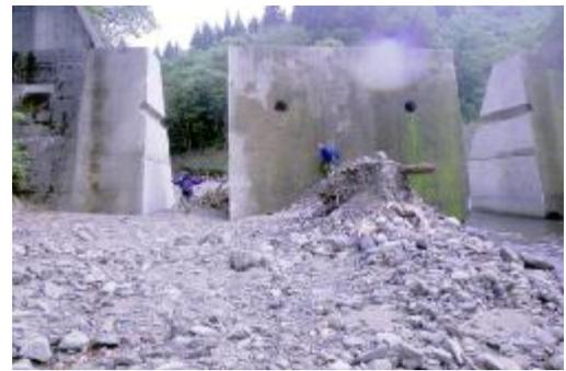
写真2 スリット化工事が完了した砂防ダム
