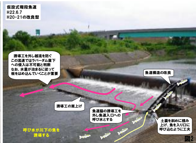
図2 改良後の仮設式階段魚道と誘導工の設置
