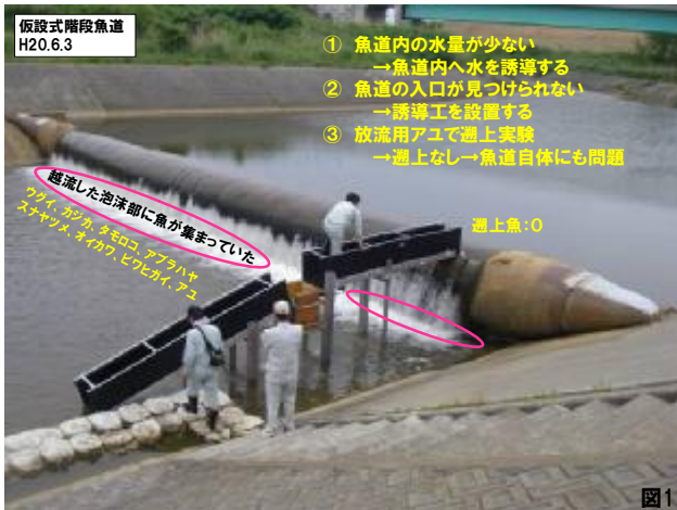
図1 最初に設置された仮設式階段魚道
