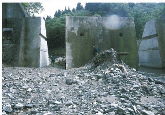
「スリット化された砂防ダム」
