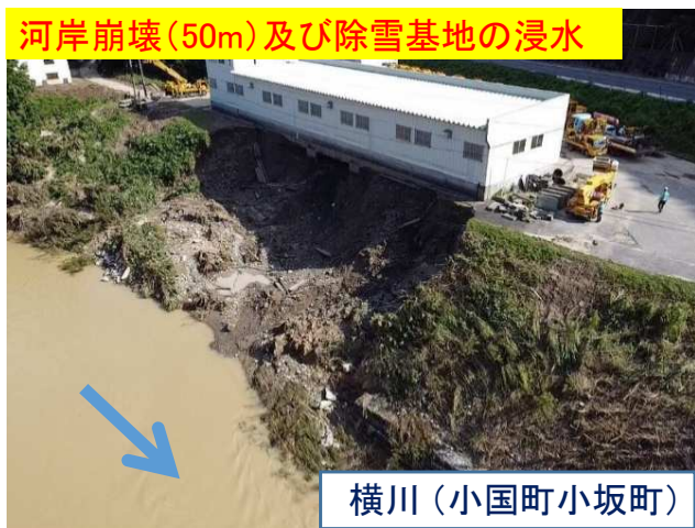
県道橋・JR橋流失、家屋浸水
