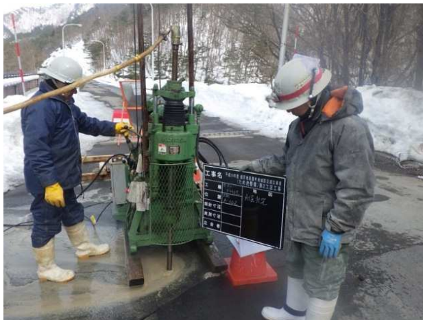
① 注入孔の削孔
