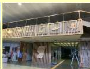
公共施設の内装木質化 (山形県庁ロビー)
