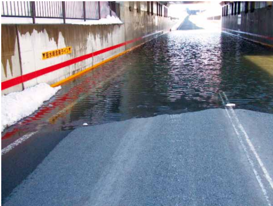
【一般県道曲川新庄線桧町アンダーパス（路面冠水）】
