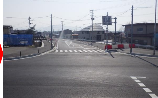
② 現道状況 (H30年3月 暫定完成)
